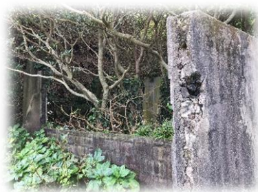
鳥打小中学校の外壁
